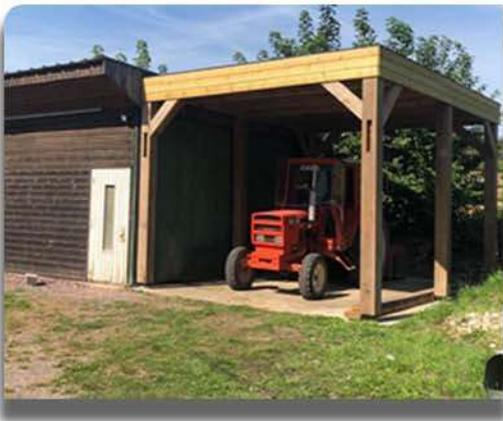
La commune avait stocké depuis des années l'ancienne charpente de la salle des fêtes. Afin de libérer de la place dans le local technique et sur un autre lieu de stockage, un carport a été construit au niveau d'une dalle béton déjà existante. Afin d'éviter des problèmes de moisissures des gouttières ont été également installées sur toute la longueur du bâtiment ainsi que deux spots extérieur à LED.
